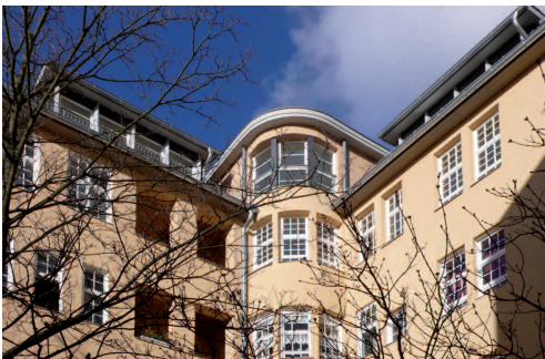
Dachausbau zum Hof
