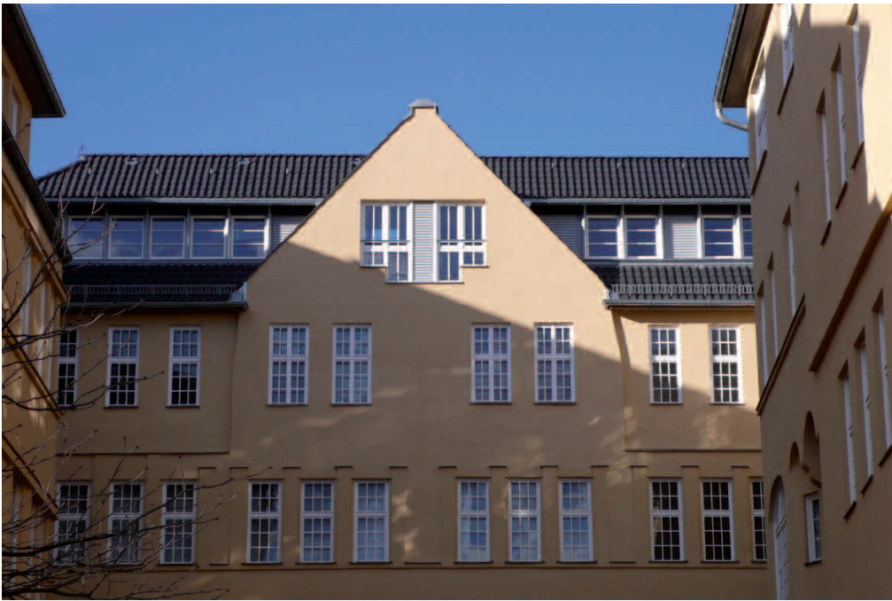
Mittelrisalit im Erschließungshof
